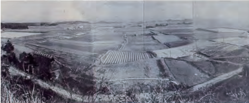
建築前の上ヶ原校地(上ヶ原)1927(昭和2)年
